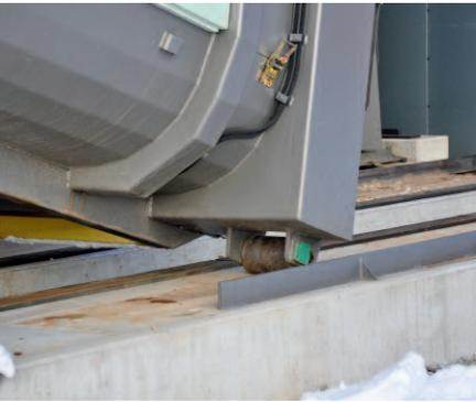
Ein bißchen Übung gehört auch dazu, aber vor allem sorgen die Schienen auf dem Betonsockel dafür, daß der Container in die richtige Position für die Luftanschlüsse rollt (oben). Zum Anschlag hin verjüngen sich die Schienen, so daß kaum Spiel bleibt. Durch den Anschlag wird der Container dann automatisch gestoppt (unten).
