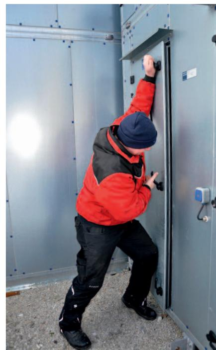
**Um die Tür zur Druckkammer zu schließen, ist schon Kraft nötig. Die Druckkammer sorgt dafür, daß der Luftstrom gleichmäßig durch das Heizregister strömt.**
